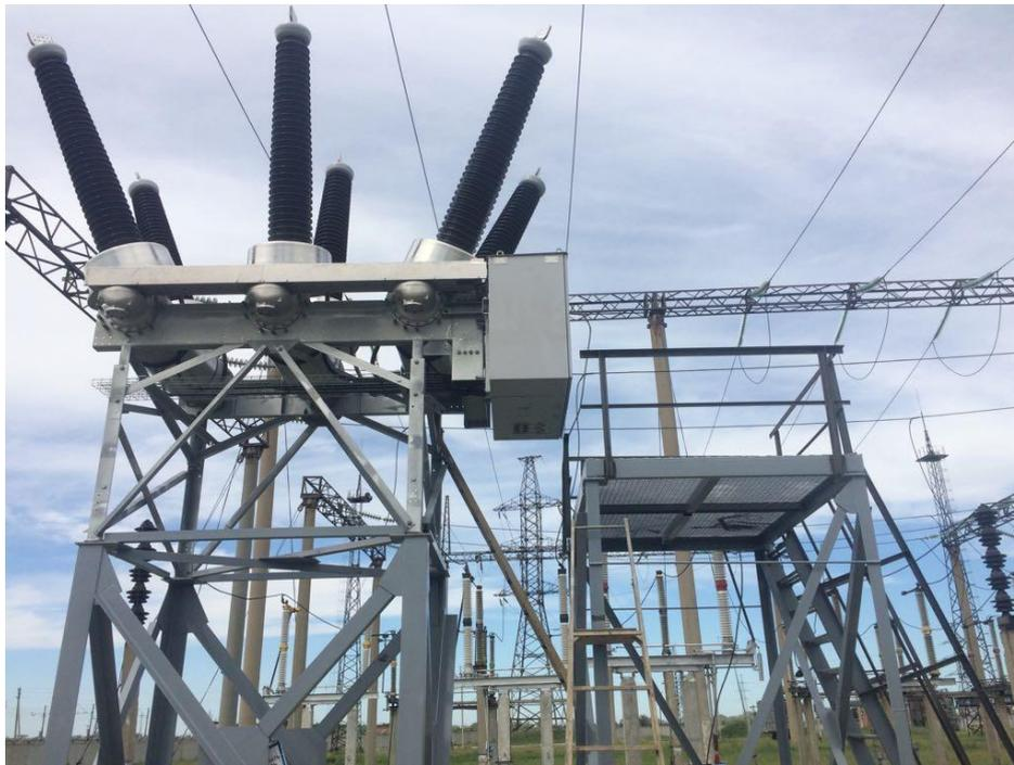
Рисунок 8.1.6. Замена выключателя 220 кВ на ПС 220 кВ Урожай
