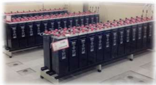
Рисунок 8.1.6. Аккумуляторная батарея, зарядно-выпрямительное устройство и щиты постоянного тока ПС Дружная
