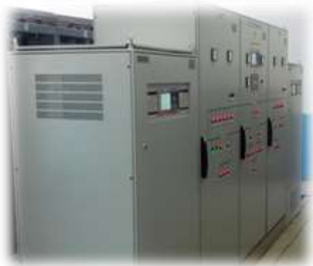
Рисунок 8.1.6. Аккумуляторная батарея, зарядно-выпрямительное устройство и щиты постоянного тока ПС Дружная
