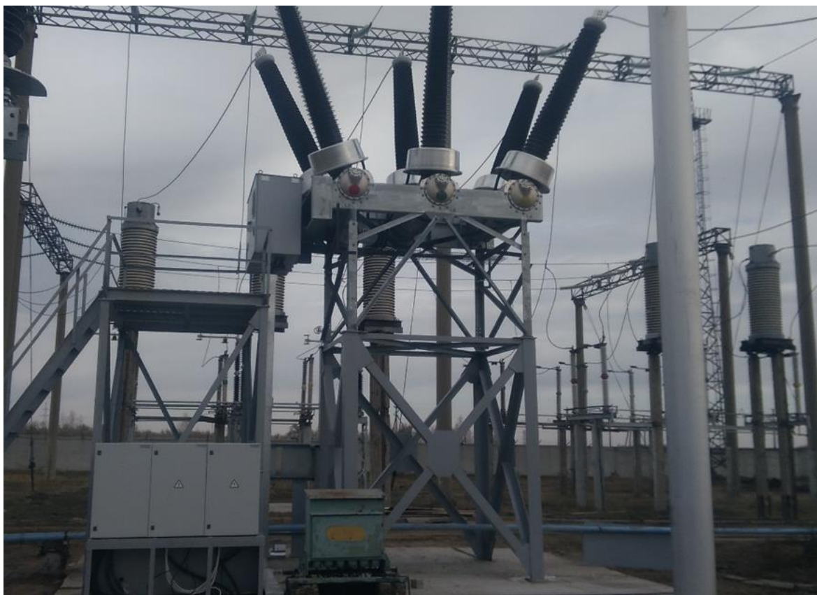
Рисунок 8.1.6. Замена выключателя 220 кВ на ПС 220 кВ Урожай
