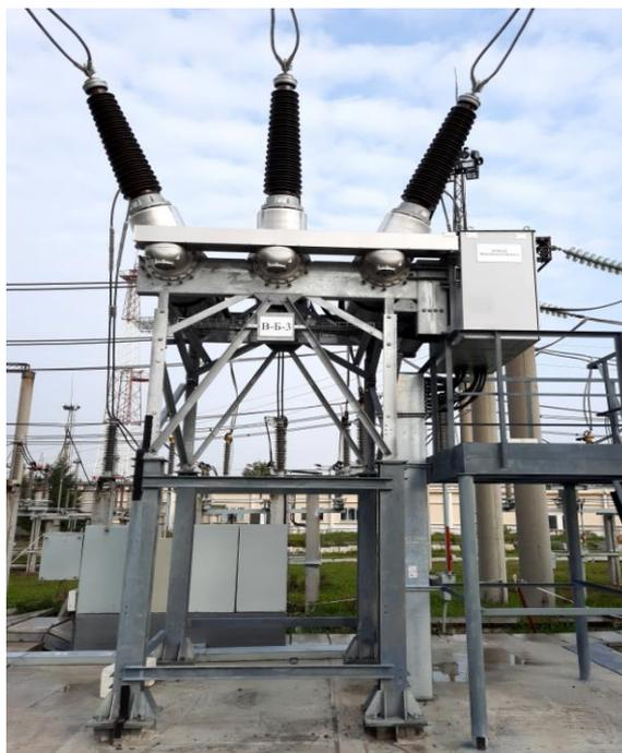
Рисунок 8.1.6. Замена выключателя 110 кВ на ПС 220 кВ Восточная
