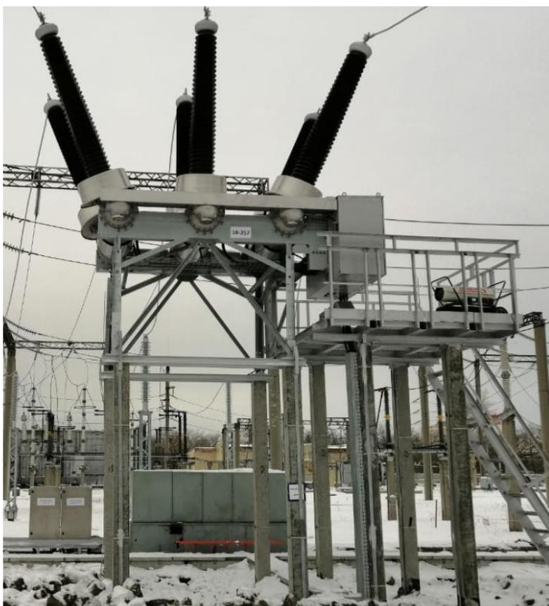
Рисунок 8.1.8. Замена выключателя 220 кВ на ПС 220 кВ Тулинская
