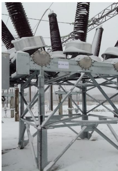
Рисунок 8.1.6. Замена выключателя 220 кВ на ПС 220 кВ Восточная
