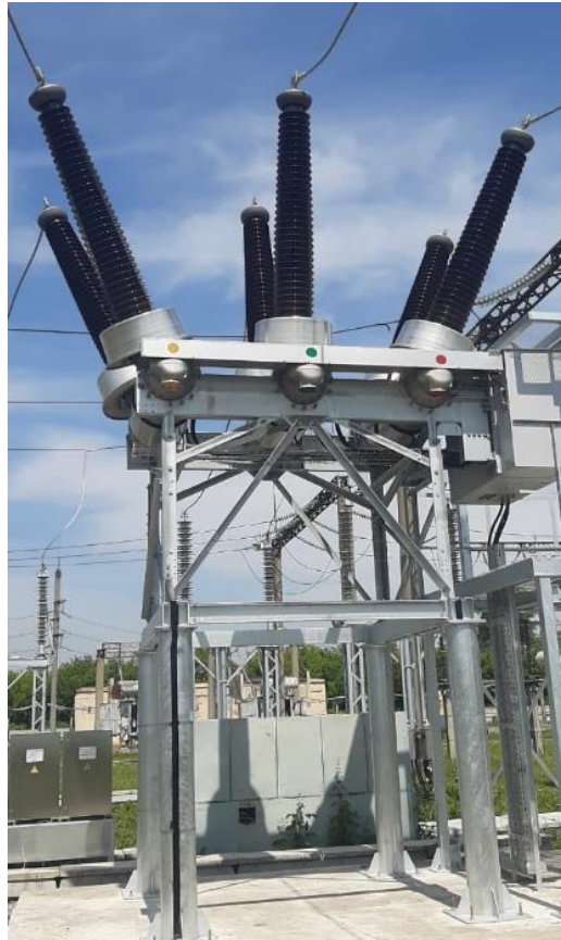
Рисунок 8.1.7. Замена выключателей 220 кВ на ПС 220 кВ Тулинская
