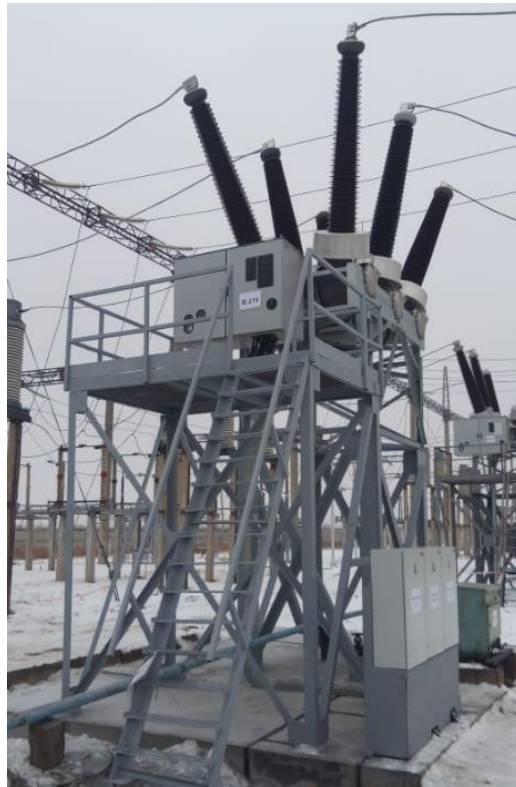
Рисунок 8.1.8. Замена выключателей 220 кВ на ПС 220 кВ Урожай
