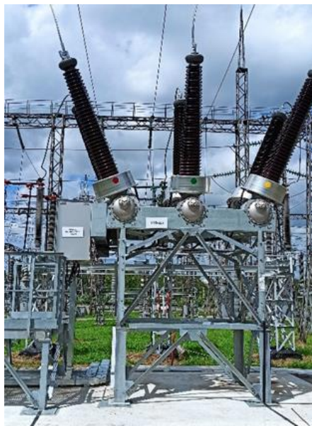
Рисунок 9.1.9. Замена выключателя 220 кВ на ПС 220 кВ Восточная
