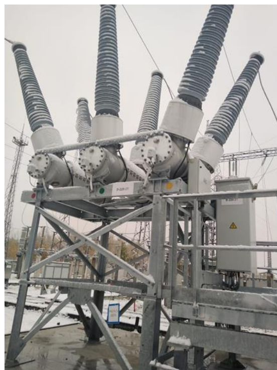
Рисунок 9.1.10. Замена выключателей 220 кВ на ПС 220 кВ Строительная
