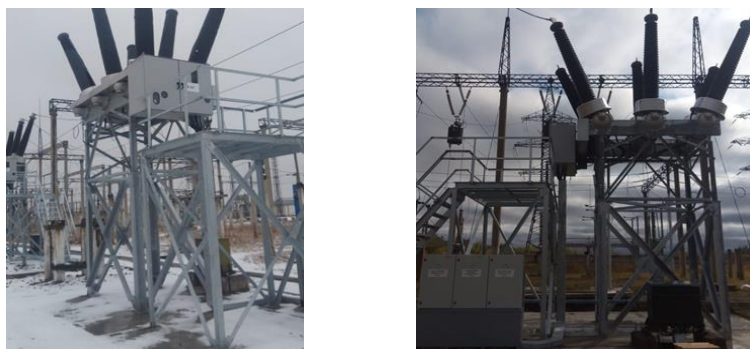
Рисунок 9.1.8. Замена выключателей 220 кВ на ПС 220 кВ Урожай
