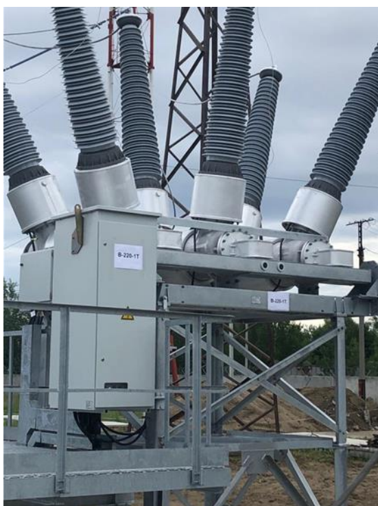
Рисунок 9.1.10. Замена выключателей 220 кВ на ПС 220 кВ Строительная
