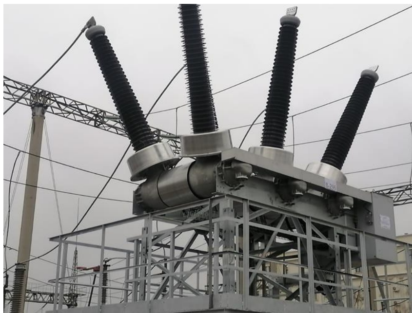
Рисунок 9.1.11. Замена выключателя 220 кВ на ПС 220 кВ Правобережная
