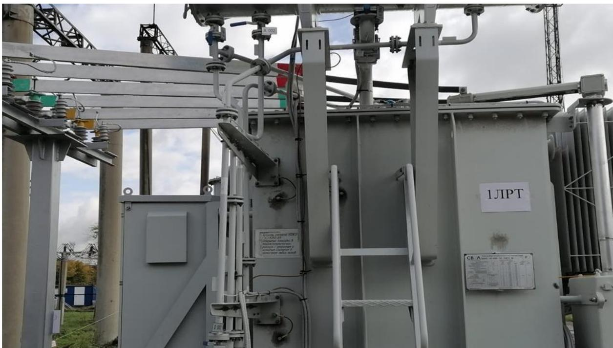
Рисунок 8.1.10. Реконструкция ПС 220 кВ Тулинская в части замены существующего линейного регулировочного трансформатора (1ЛРТ) с увеличением мощности на 23 МВА до 63 МВА и выполнением сопутствующего объема работ
