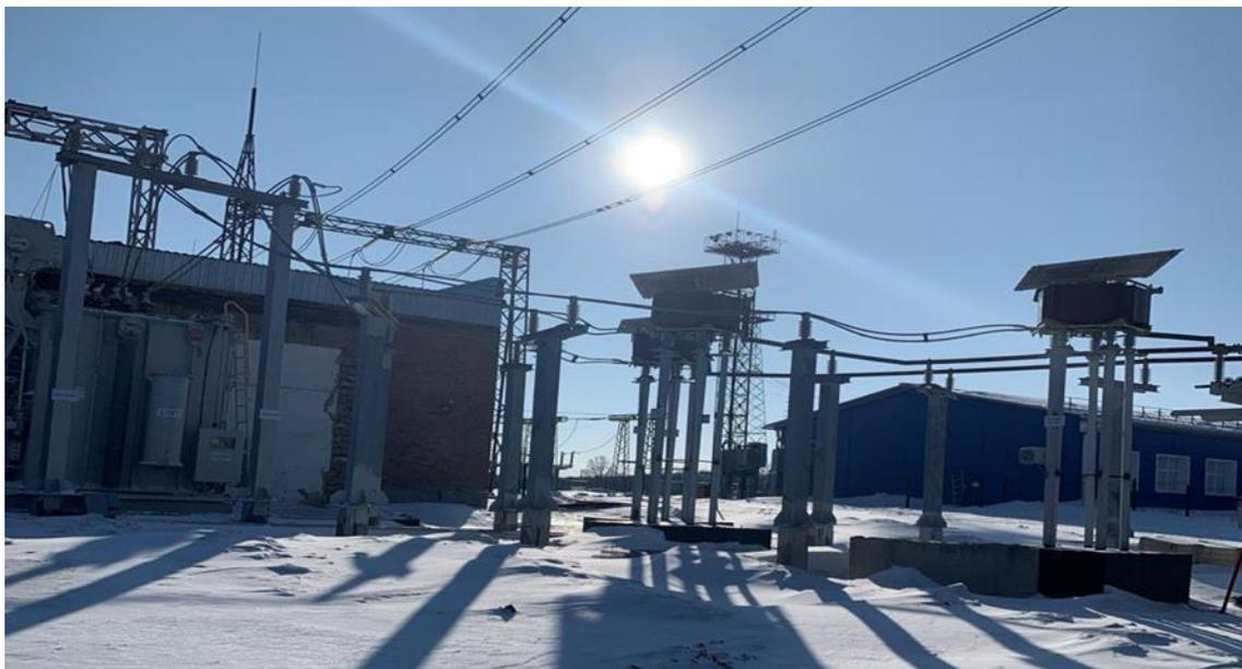
Рисунок 8.1.8. Реконструкция ПС 220 кВ Южная в части установки линейных регулировочных трансформаторов (2 шт.) мощностью 16 МВА, демонтажа трансформатора 3Т мощностью 16 МВА с выполнением сопутствующего объема работ
