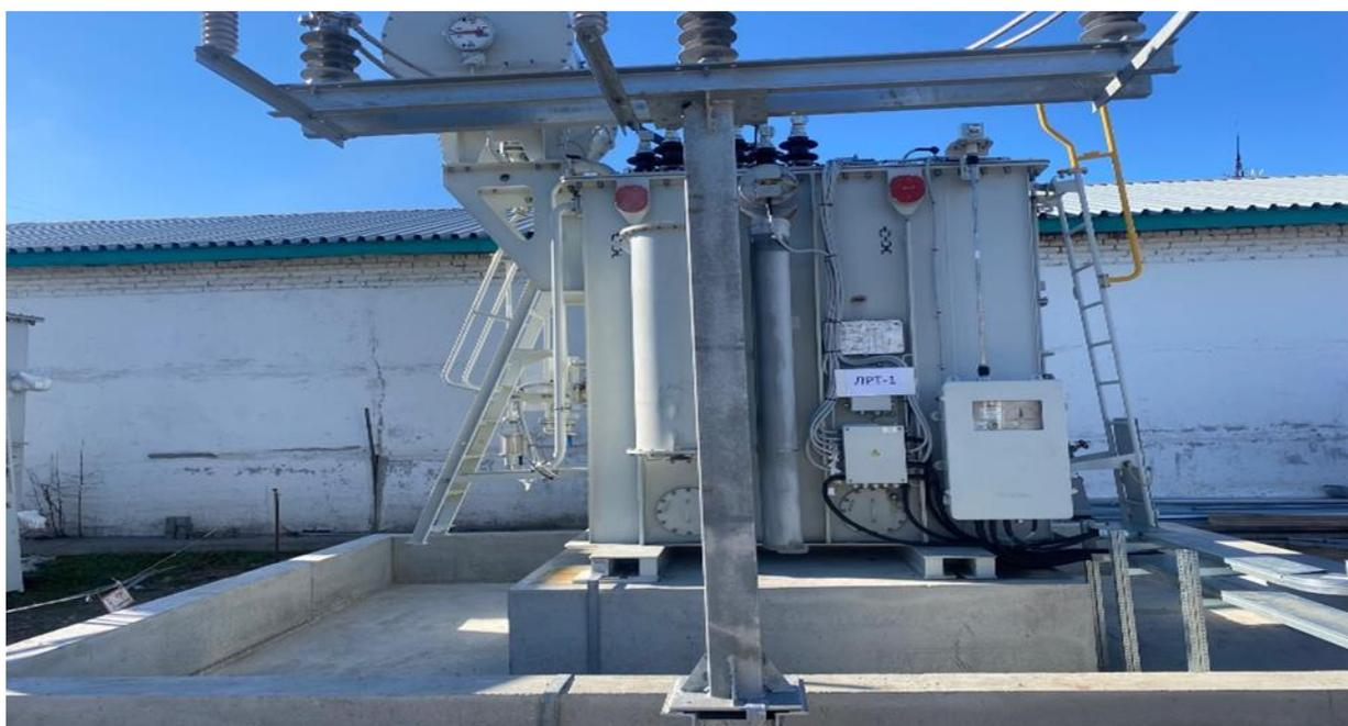
Рисунок 8.1.11. Реконструкция ПС 220 кВ Урожай в части установки линейного регулировочного трансформатора (2 шт.) мощностью 16 МВА, ячеек ЗРУ 10 кВ с выполнением сопутствующего объема работ
