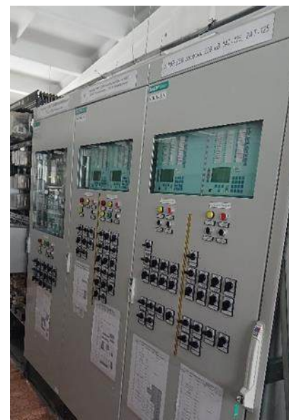
Рисунок 8.1.9. Реконструкция ПС 220 кВ Правобережная замена масляных выключателей (3 шт.) на элегазовые выключатели с реконструкцией УРЗА (8 шт.), заменой разъединителей (12 шт.) и выполнением сопутствующего объема работ
