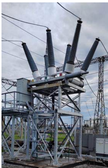
Рисунок 8.1.10. Комплексная реконструкция ПС 220 Чулымская замена масляных выключателей (4 шт.) на элегазовые выключатели с реконструкцией УРЗА (12 шт.), заменой разъединителей (14 шт.), заменой ячеек КРУН (28 шт.) и строительством здания ОПУ-ЗРУ с выполнением сопутствующего объема работ
