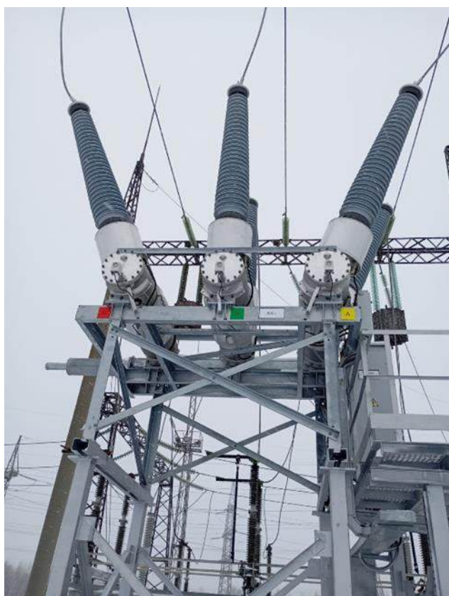
Рисунок 8.1.8. Реконструкция ПС 220 кВ Восточная замена масляных выключателей (7 шт.) на элегазовые выключатели с реконструкцией УРЗА (21 шт.), заменой разъединителей (25 шт.) и выполнением сопутствующего объема работ
