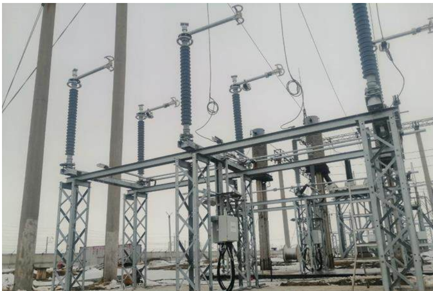
Рисунок 8.1.7. Реконструкция ПС 220 кВ Урожай замена воздушных выключателей (8 шт.) на элегазовые выключатели с реконструкцией УРЗА (28 шт.), заменой разъединителей (30 шт.) и выполнением сопутствующего объема работ
