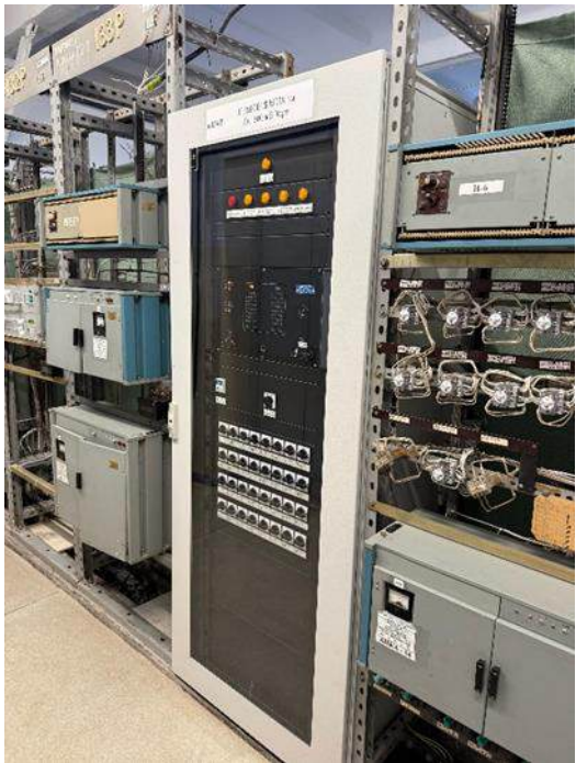
Рисунок 8.1.11. Реконструкция ПС 220 кВ Восточная в части установки устройства автоматики ограничения перегрузки оборудования (АОПО) ВЛ 110 кВ Восточная – Кошево с отпайками, ВЛ 110 кВ Восточная – Лазурная с отпайками
