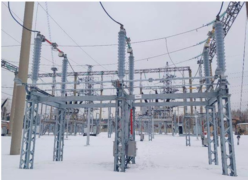
Рисунок 8.1.9. Реконструкция ПС 220 кВ Правобережная замена масляных выключателей (3 шт.) на элегазовые выключатели с реконструкцией УРЗА (8 шт.), заменой разъединителей (12 шт.) и выполнением сопутствующего объема работ
