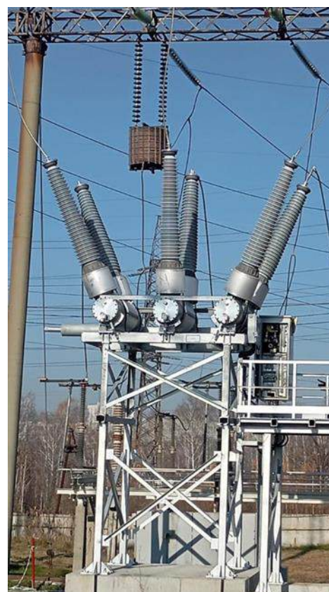
Рисунок 8.1.8. Реконструкция ПС 220 кВ Восточная замена масляных выключателей (7 шт.) на элегазовые выключатели с реконструкцией УРЗА (21 шт.), заменой разъединителей (25 шт.) и выполнением сопутствующего объема работ
