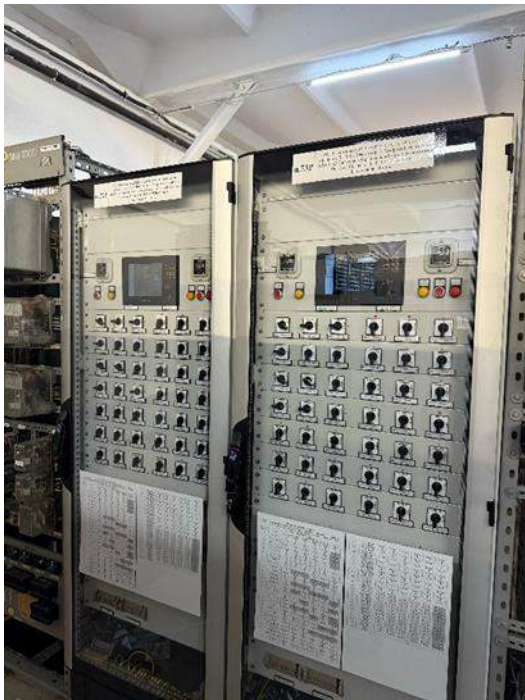
Рисунок 8.1.11. Реконструкция ПС 220 кВ Восточная в части установки устройства автоматики ограничения перегрузки оборудования (АОПО) ВЛ 110 кВ Восточная – Кошево с отпайками, ВЛ 110 кВ Восточная – Лазурная с отпайками
