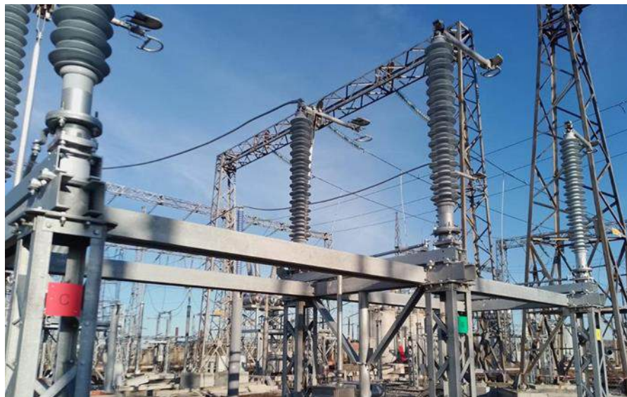
Рисунок 8.1.10. Комплексная реконструкция ПС 220 Чулымская замена масляных выключателей (4 шт.) на элегазовые выключатели с реконструкцией УРЗА (12 шт.), заменой разъединителей (14 шт.), заменой ячеек КРУН (28 шт.) и строительством здания ОПУ-ЗРУ с выполнением сопутствующего объема работ
