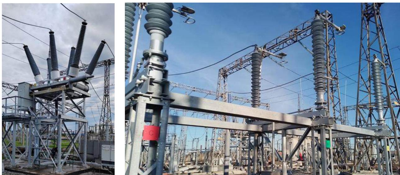
Рисунок 8.1.10. Комплексная реконструкция ПС 220 Чулымская замена масляных выключателей (4 шт.) на элегазовые выключатели с реконструкцией УРЗА (12 шт.), заменой разъединителей (14 шт.), заменой ячеек КРУН (28 шт.) и строительством здания ОПУ-ЗРУ с выполнением сопутствующего объема работ
