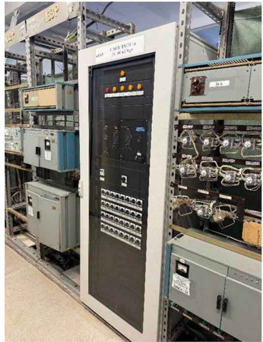
Рисунок 8.1.11. Реконструкция ПС 220 кВ Восточная в части установки устройства автоматики ограничения перегрузки оборудования (АОПО) ВЛ 110 кВ Восточная – Кошево с отпайками, ВЛ 110 кВ Восточная – Лазурная с отпайками
