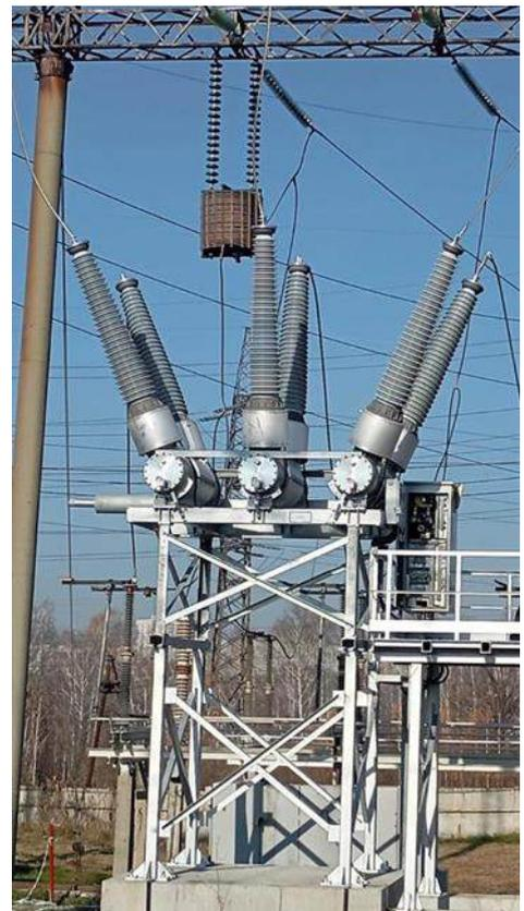
Рисунок 8.1.8. Реконструкция ПС 220 кВ Восточная замена масляных выключателей (7 шт.) на элегазовые выключатели с реконструкцией УРЗА (21 шт.), заменой разъединителей (25 шт.) и выполнением сопутствующего объема работ
